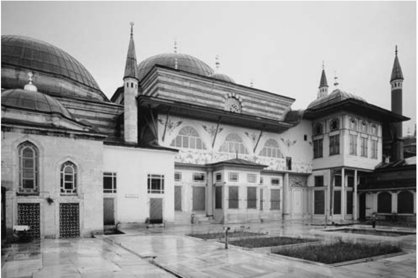
Abb. 2: Das Sultan Ahmet III.-Zimmer (mit dem turmartigen Schornstein links) von Norden. Rechts der Thronsaal, links vorne der Leseraum von Ahmet I., links hinten der Pavillon von Murat III. (Foto: A. Neftçi).
